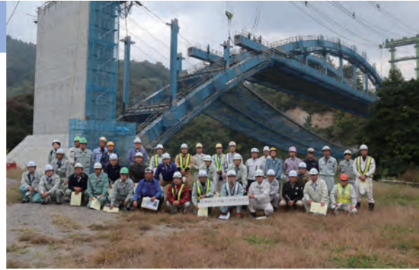
笠倉壁田橋 鋼ローゼ橋架設工事
