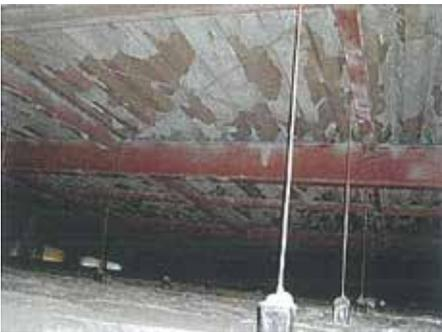
写真の状況：折板屋根において、気温や風圧による折板屋根の収縮や振動での脱落が見られる。
