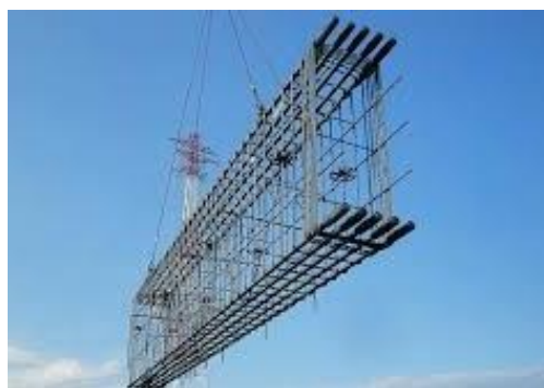
梁鉄筋地組取付
