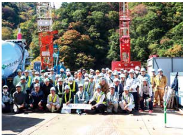
8号橋梁の仮設構台の上で
