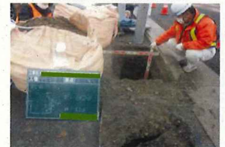
【試掘による確認】
