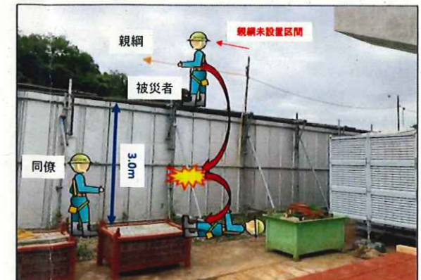
未終了の足場板上を歩行し、足元の足場板が傾斜したことによりバランスを崩し、地上へ墜落した事案
