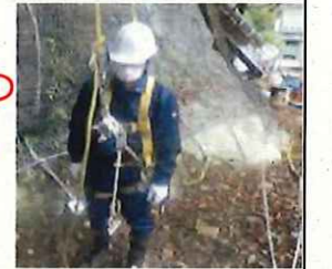
【墜落制止用器具の使用】
