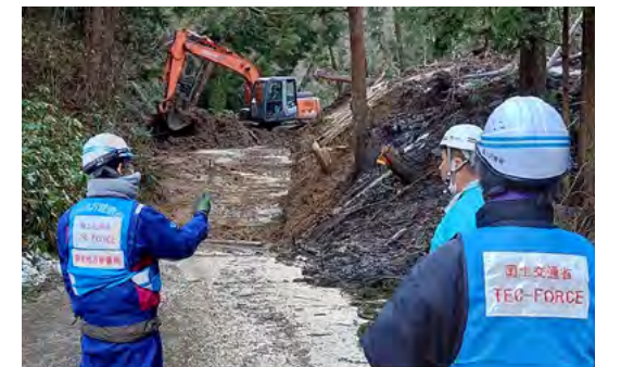
図3:建設業者と連携した道路の緊急復旧(石川県輪島市)
