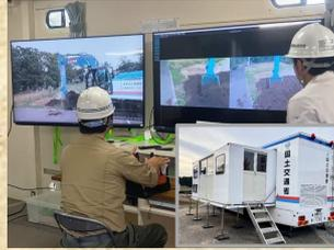
地震や豪雨災害などへの対応として、国土交通省では遠隔操作式バックホウを配備しています。
