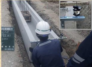
小規模構造物の設置に丁張はもう不要。3次元設計データとTSを使用することで、小規模構造物(今回はU字側溝)の据付を、平面位置管理や標高管理をせずに、1人施工が可能になります。
